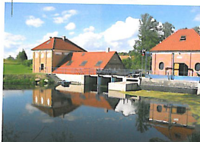
Elektrownia wodna w Ołowniku
